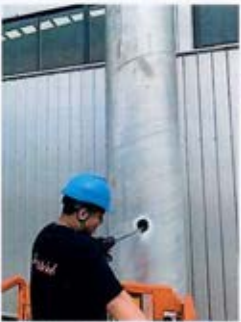
◎3 大热浸锌燃气镀锌锅排气筒 P10
